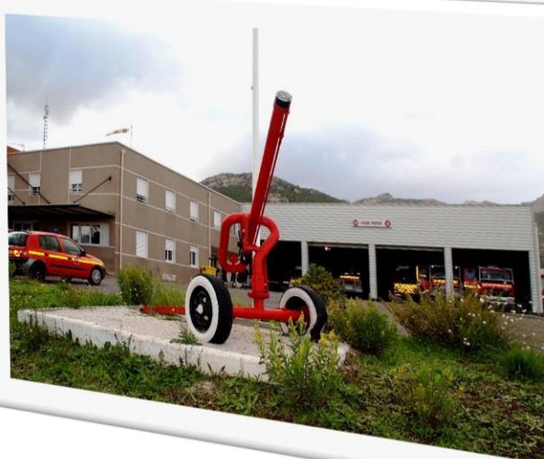
La nouvelle caserne tant attendue
