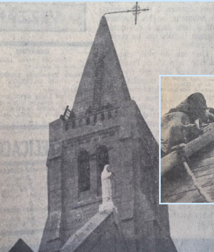
Intervention périlleuse des sapeurs-pompiers de Bastia sur le clocher de l'église de Notre Dame de Lourdes - 21 janvier 1967.
