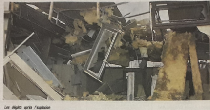
Les débris après l'explosion
